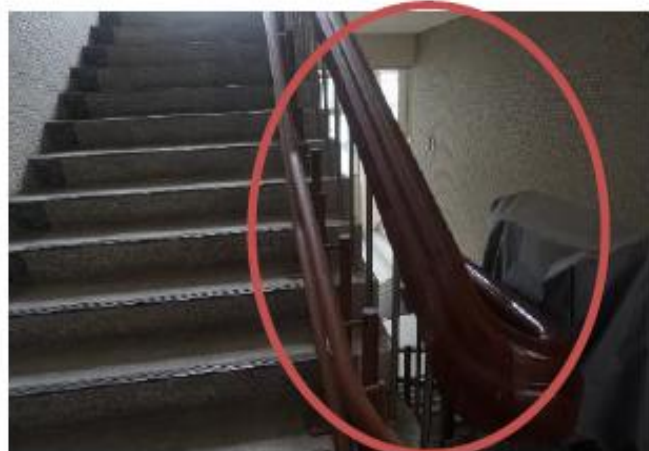
樓梯拖淨及扶手灰塵擦拭
