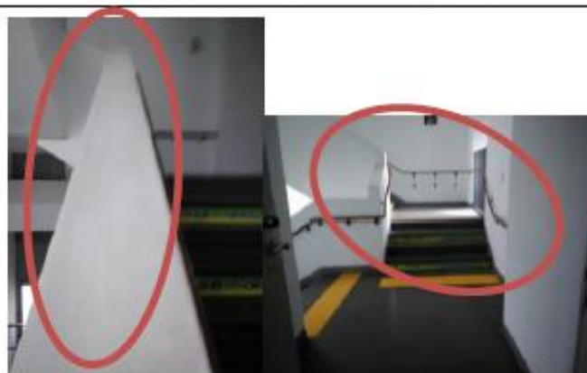
樓梯扶手塵擦拭
