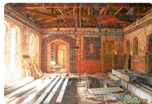
▲ 工事進行中的紅樓
